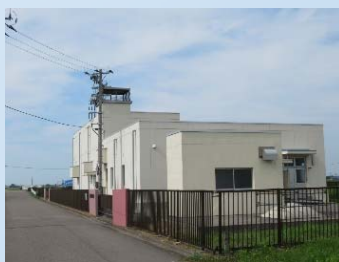
岩室(第4)ポンプ場(西川流域)
